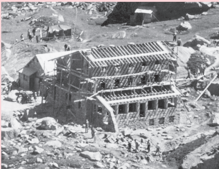
Il cantiere del Rifugio Zamboni-Zappa
