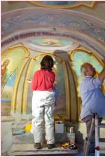
Durante il restauro
