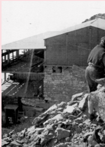
Gressoney La Trinité, anni ‘60. Al Garstlet Monte Rosa, si lavora per la costruzione della nuova Capanna Gnifetti
