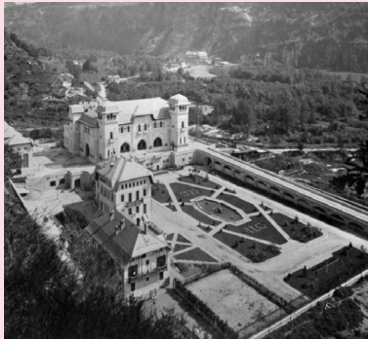
La centrale di Verampio
