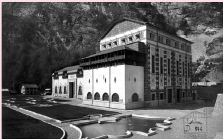
La centrale di Cadarese
