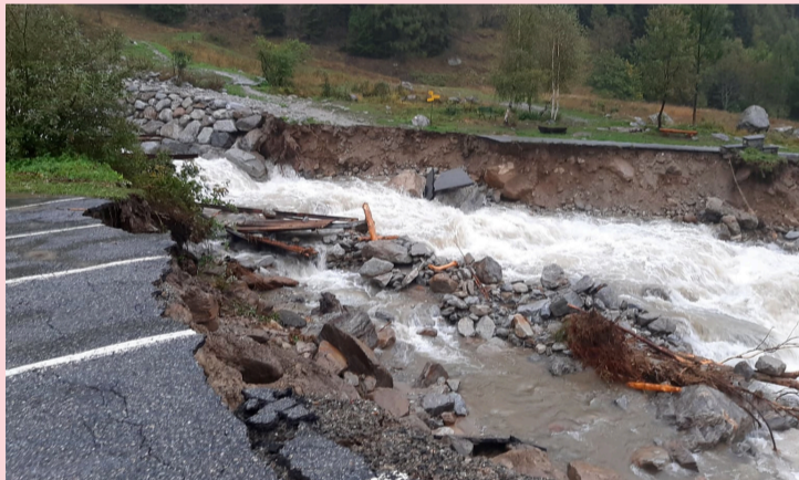
Pecetto: gli ingenti danni causati dal torrente Tambach. (© Mattia Marone)
