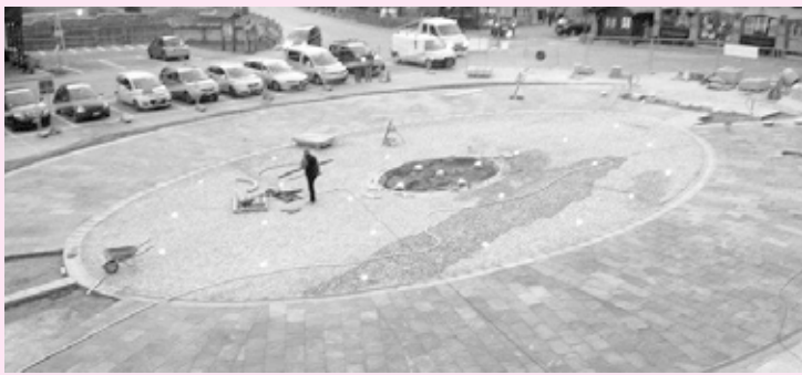
Piazza Municipio, lavori in corso. (Foto: Francesca Iulita)
