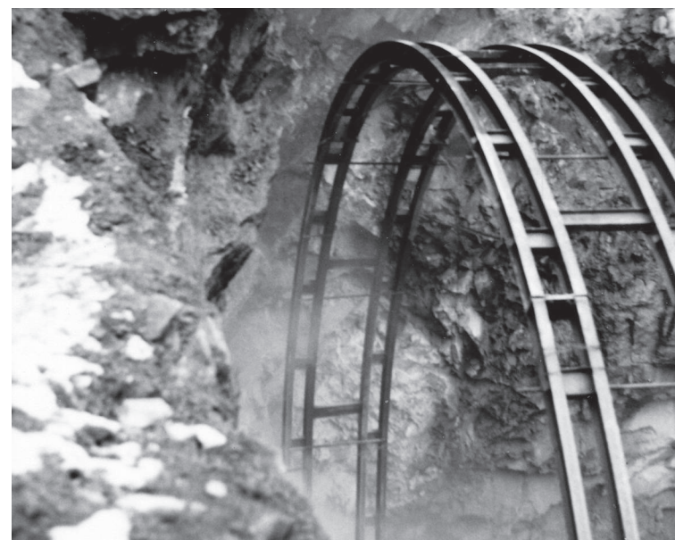
1982, la posa della prima centina della costruenda galleria di Stabioli.
