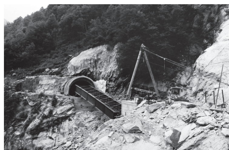
Il montaggio del nuovo ponte sul rio Mondelli.
