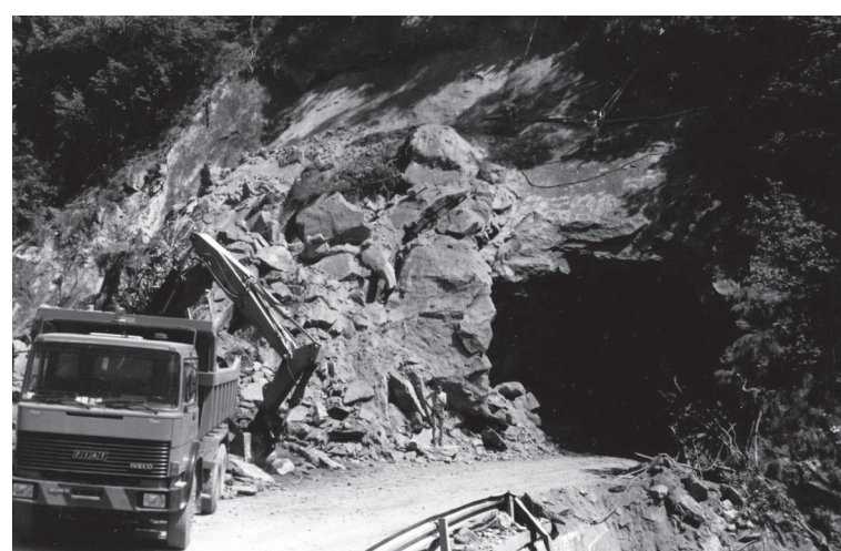
La vecchia strada all'uscita delle gallerie di sasso sotto a Stabioli.
