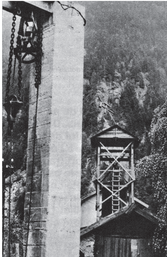
Pestarena - Le installazioni al Pozzo maggiore
